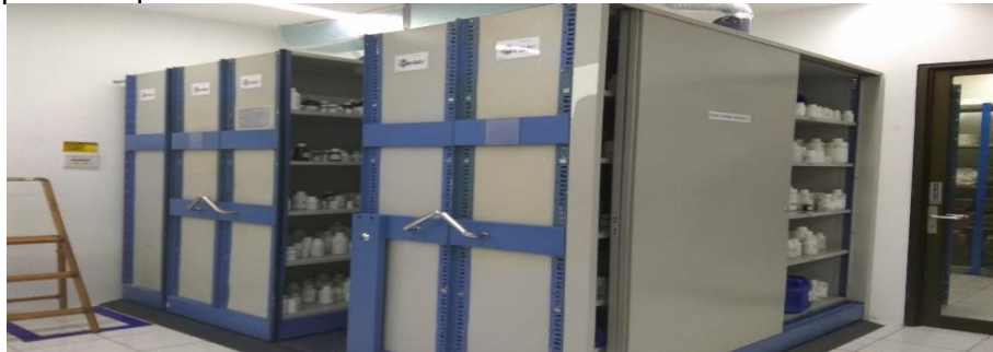
Gambar 8 Warehouse sebelum di perbaiki
