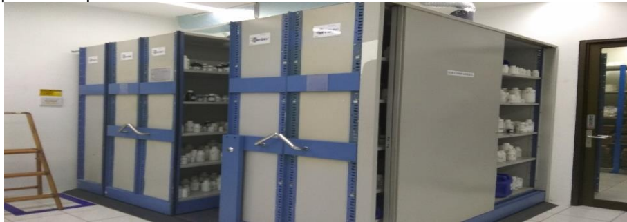
Gambar 8 Warehouse sebelum di perbaiki
